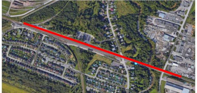
Zone de travaux
