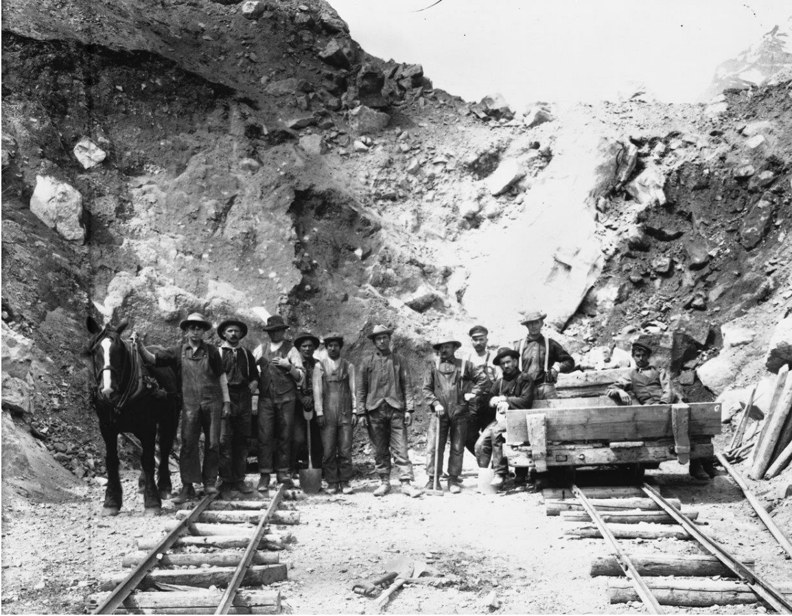
Crédit photo : Exporail, Fonds Canadian Pacific Railway Company Construction du tunnel double spirales sur la subdivision Laggan. 1909 - ID : A.25283
